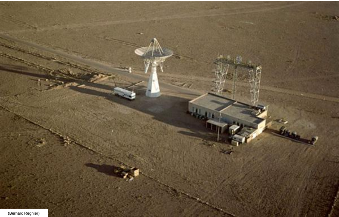
La station de télémesure à Hammaguir avec l'antenne géante Cyclope qui pèse 35 tonnes et mesure 27 mètres de hauteur
