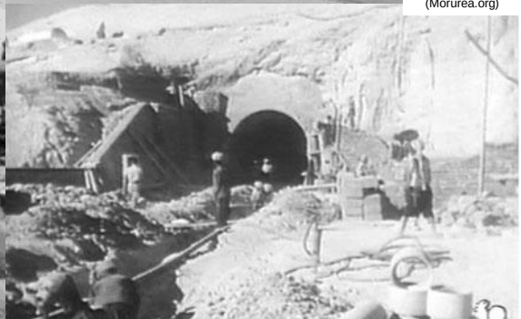
Construction d'un laboratoire souterrain
