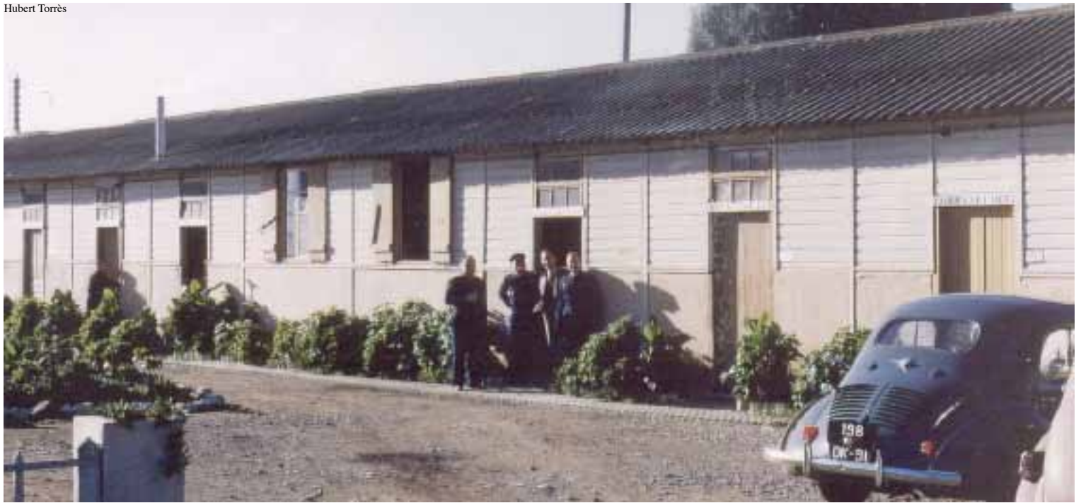
▲ Les installations de l'ERALA 1/40 à Maison-Blanche
